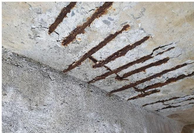
Foto 6: Espulsione di copriferro e armature corrose con perdita di sezione
