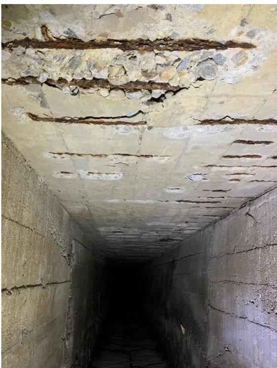
Foto 3: Porosità del calcestruzzo, espulsione di copriferro e armature corrose con perdita di sezione
