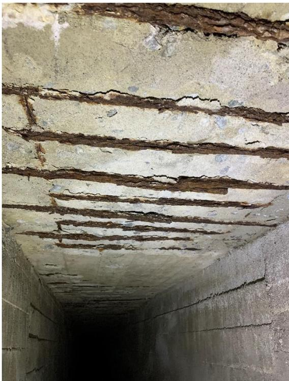
Foto 1: Espulsione copriferro, armature corrose, riduzione sezione barre.
