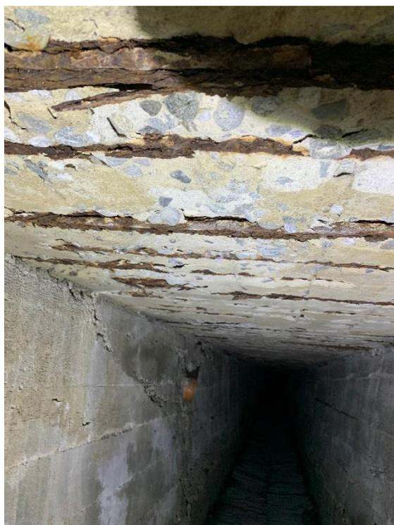
Foto 4: Armature corrose con perdita di sezione
