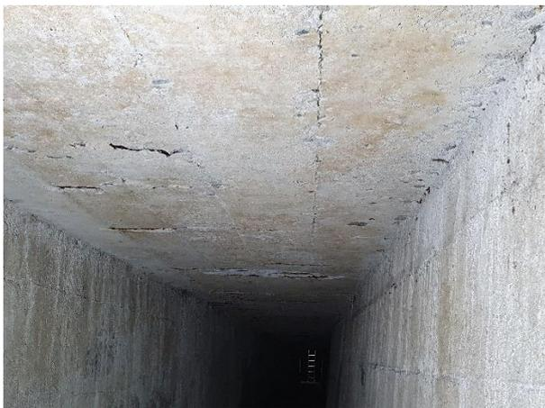
Foto 5: Espulsione di copriferro e processo di rigonfiamento delle armature attivo
